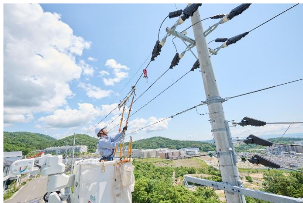
（関西電力送配電株式会社作業中の様子）
